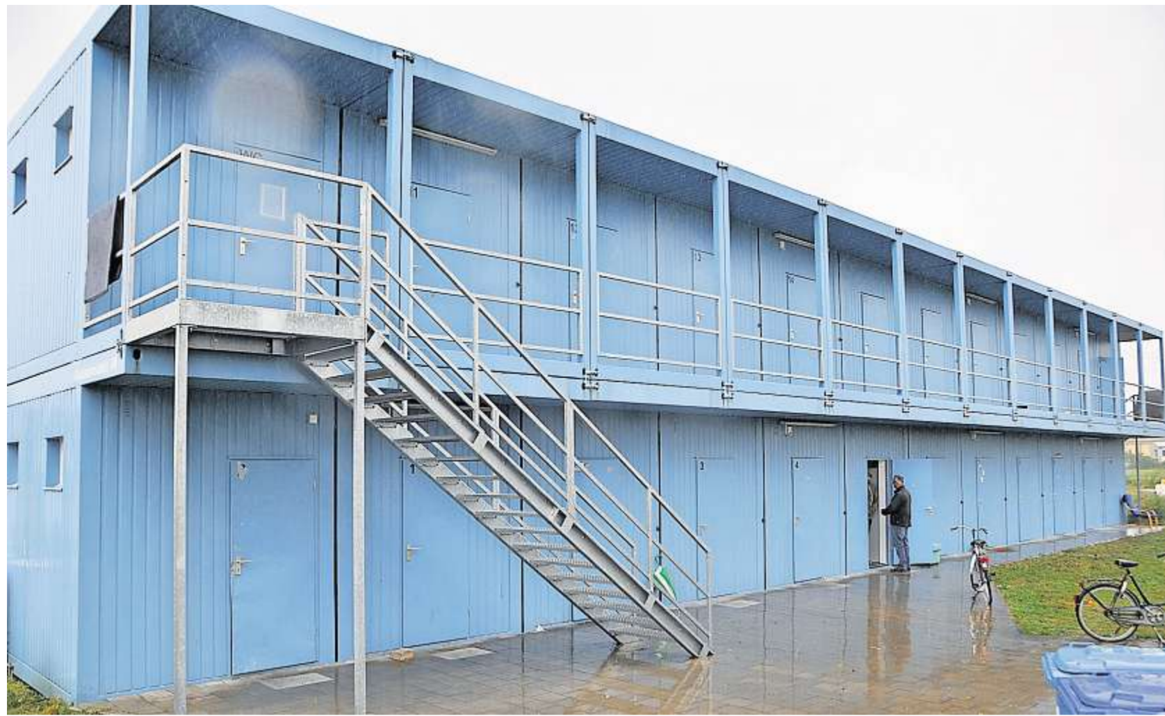
Die Stadt Neumarkt hält Notunterkünfte für Obdachlose in Form von Wohnungen und Containern wie hier in der Goldschmidtstraße bereit. FOTO: ENDLEIN
