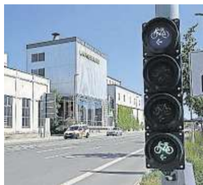
Neuartige Fahrradstreifen und Fahrradampeln wurden zum Beispiel im Bereich der Lammsbräu-Kreuzung installiert.
